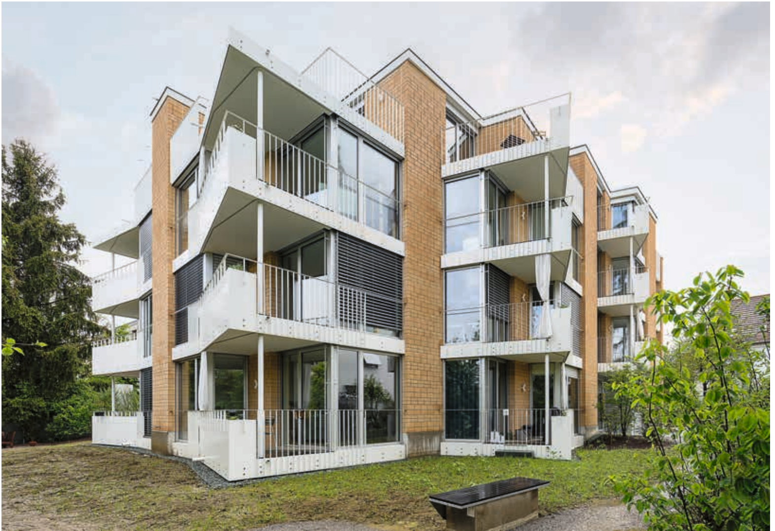
Ein «Tannzapfen» aus hellem Backstein und strahlend weissen Stahlelementen. Strassenabgewandte Fassade.
