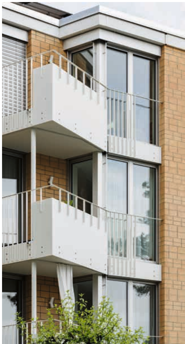
Mal flächig, mal raumhaltig. Die weissen Balkone springen spitzwinklig aus der ebenen Backsteinfassade hervor.
