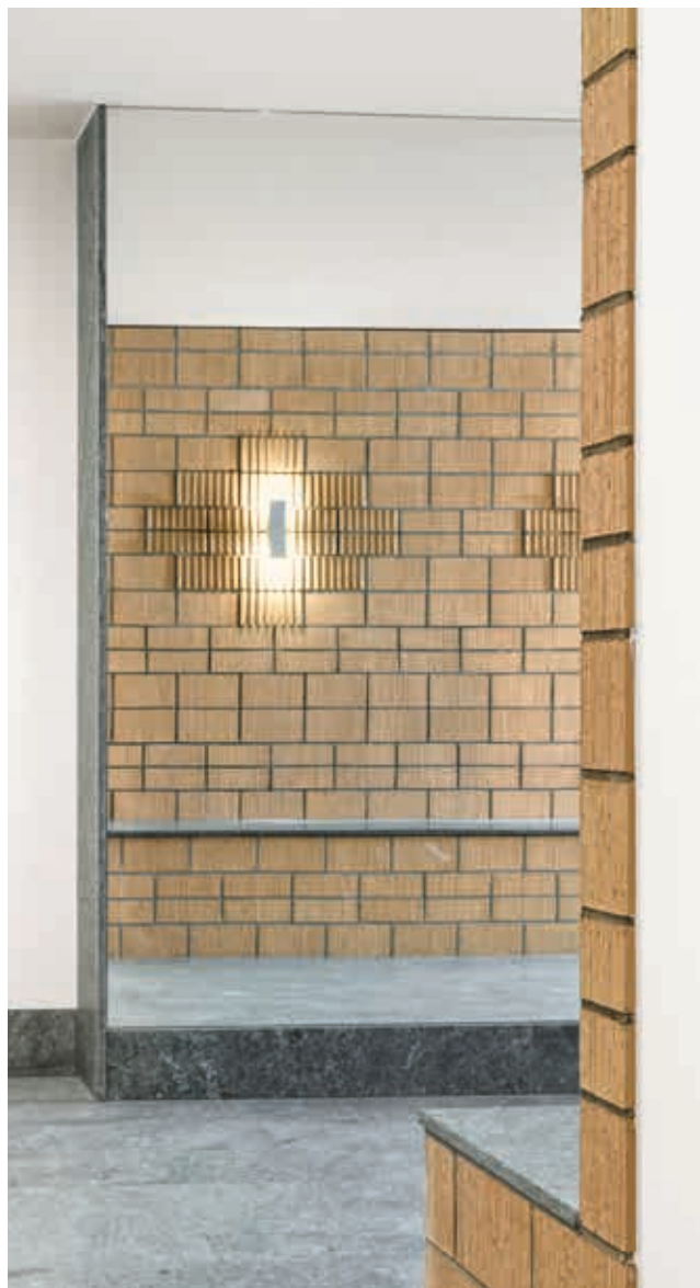
Das gestalterische Potenzial des Backsteins entfaltet seine Wirkung: Im Eingangsbereich sind die Backsteine um die Leuchten herum aufgesägt vermauert.
