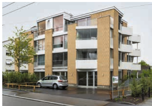
Die symmetrische Hauptfassade zur Strasse ist in der Mitte leicht geknickt.
