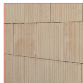
4. Sauberes und mass- genaues Mauerwerk
