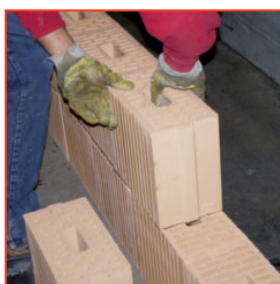
3. Versetzen EcoModul
