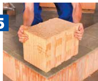
Mauerstein vollflächig auflegen
