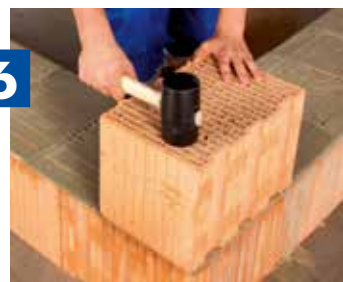
Mauerstein wie gewohnt ausrichten
