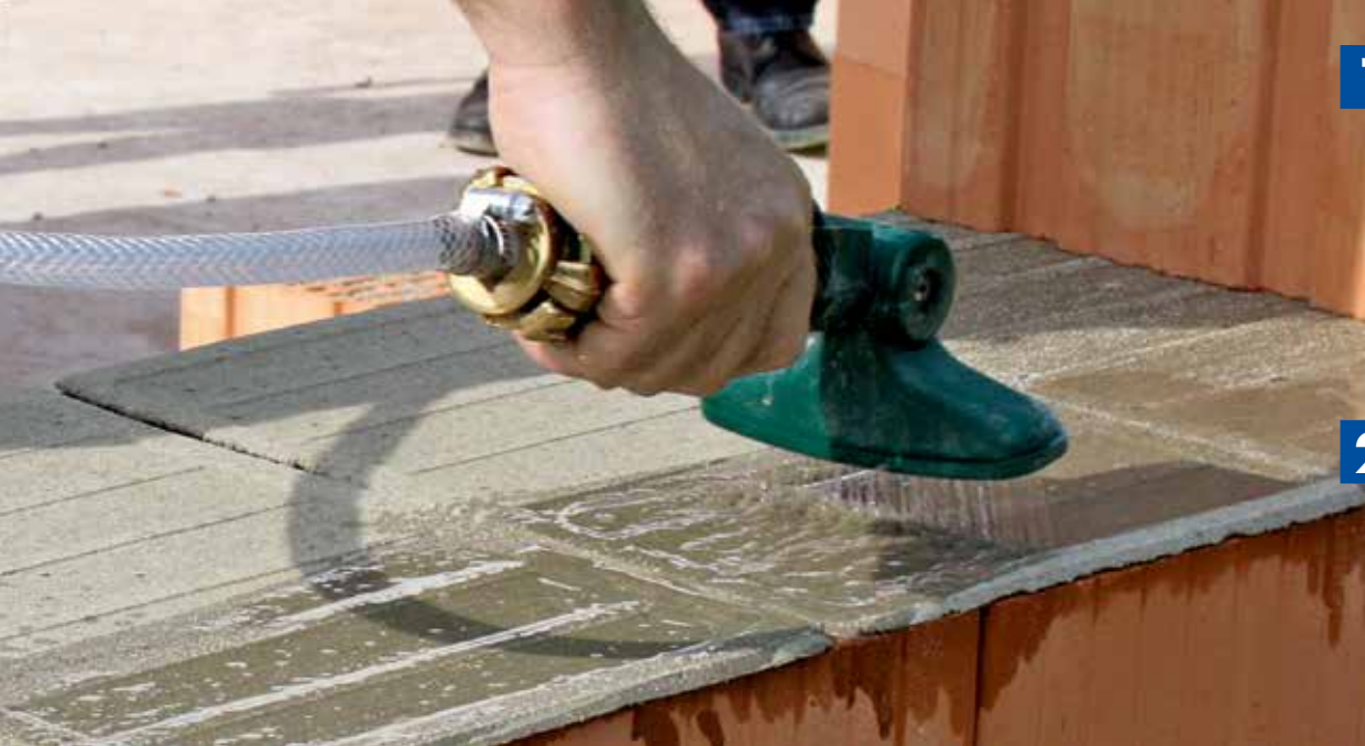
Mauersteine befeuchten
