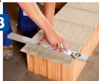
Bei Bedarf zuschneiden
